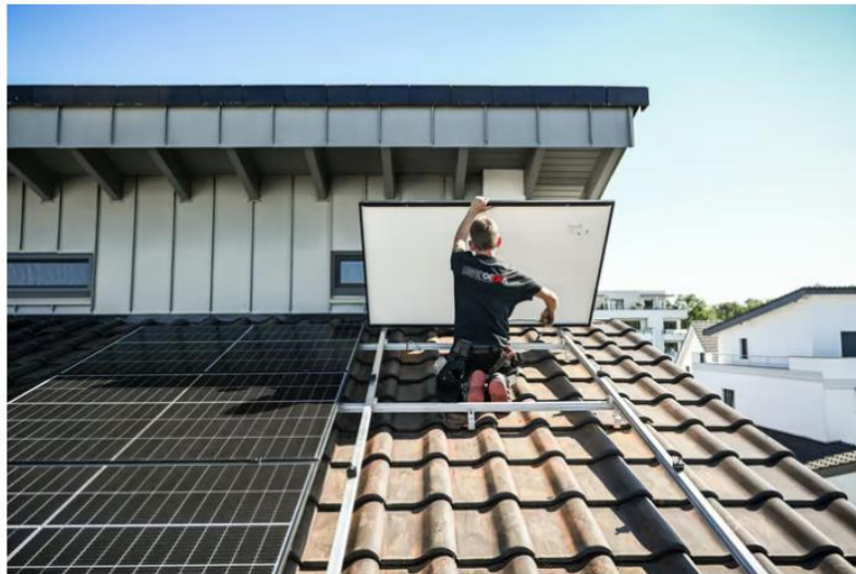
Ein Dachdecker installiert eine Photovoltaikanlage auf dem Dach eines Wohnhauses. Foto: Julia Steinbrecht/KNA
