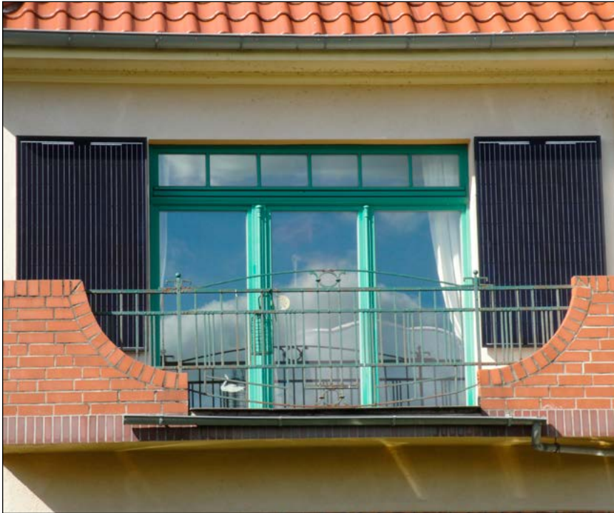
Bild 1: Zwei Steckersolareräte als Wandmontage auf dem Balkon
